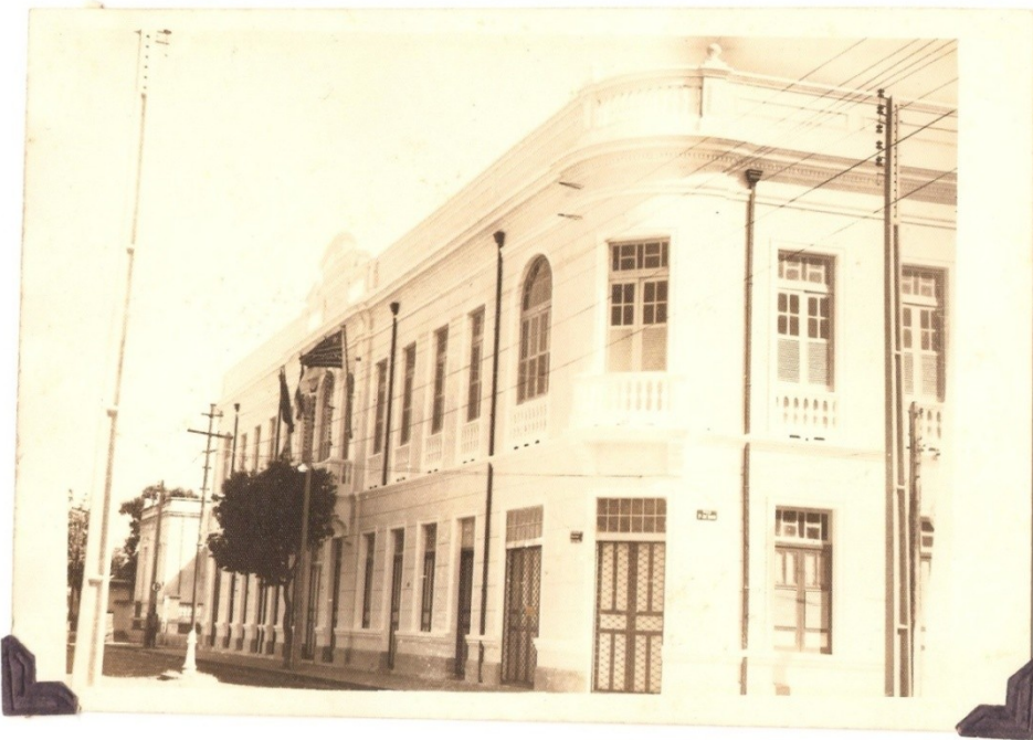
Fotografia 6: Prédio da Escola e “Sociedade Civil União Caixeiral”
